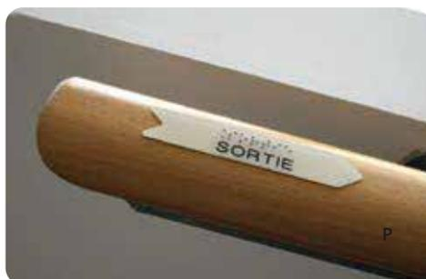
Guidage de sortie sur main courante
